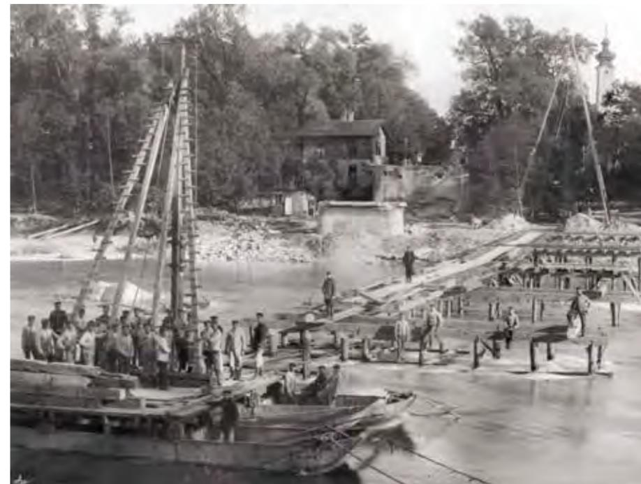
Bau einer Notbrücke durch das Militär am 17.10.1899 nach dem Einsturz der alten Brücke
