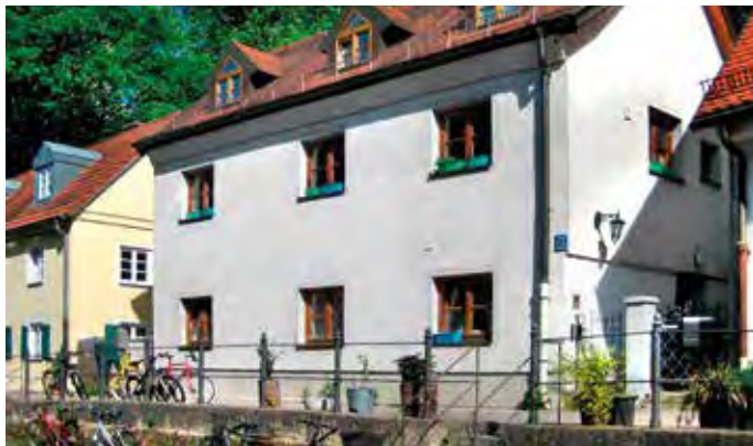
Nockherstraße 27 im Jahr 2013 vor der Sanierung von 2016
