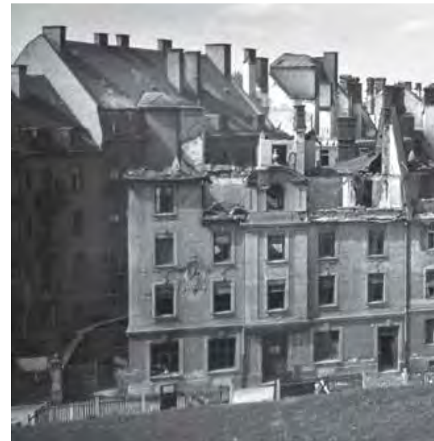
Ausschnitt aus einem Foto von 1944 auf Seite 179. Wesentlich Teile der Fassade standen noch.
