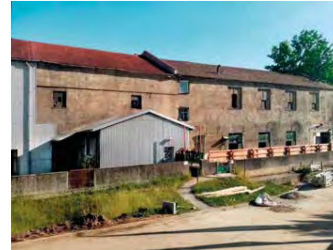
Foto 17.6.2021. Das Eiswerk kurz vor dem Abriss, nach Beseitigung der provisorischen Wellblech-Verkleidung. Bei dem Anbau handelt es sich um das Turbinenhaus.
