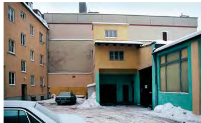
Foto oben: Blick nach Norden, vorne Haus 38, dahinter 36. Bild darunter: Blick nach Süden, links die Rückseite von Haus 36, in der Mitte das Rückgebäude von 38 (heute Hotel), rechts Lagerräume. Beide Fotos von Familie Halder 1985.
