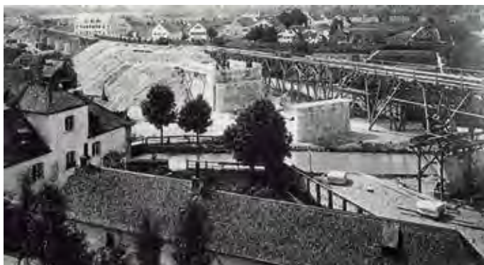
Foto von 1868. Blick vom Giesinger Berg auf die Bauarbeiten am Eisenbahndamm. Links vorne das Armenhaus. „Als erstes wurde auf der gesamten Distanz des künftigen Bahndammes ein rund sieben Meter hohes Holzgerüst errichtet, auf dem eine Rollbahn verkehrte, mit der die Erdmassen aus dem Hangeinschnitt abtransportiert und anschließend auf beiden Seiten der Holzkonstruktion hinabgekippt wurden. Auf diese Weise verschwand die Holzkonstruktion nach und nach im aufgeschütteten Eisenbahndamm.“ (Guttman, Giesing und die Eisenbahn, S. 40)
