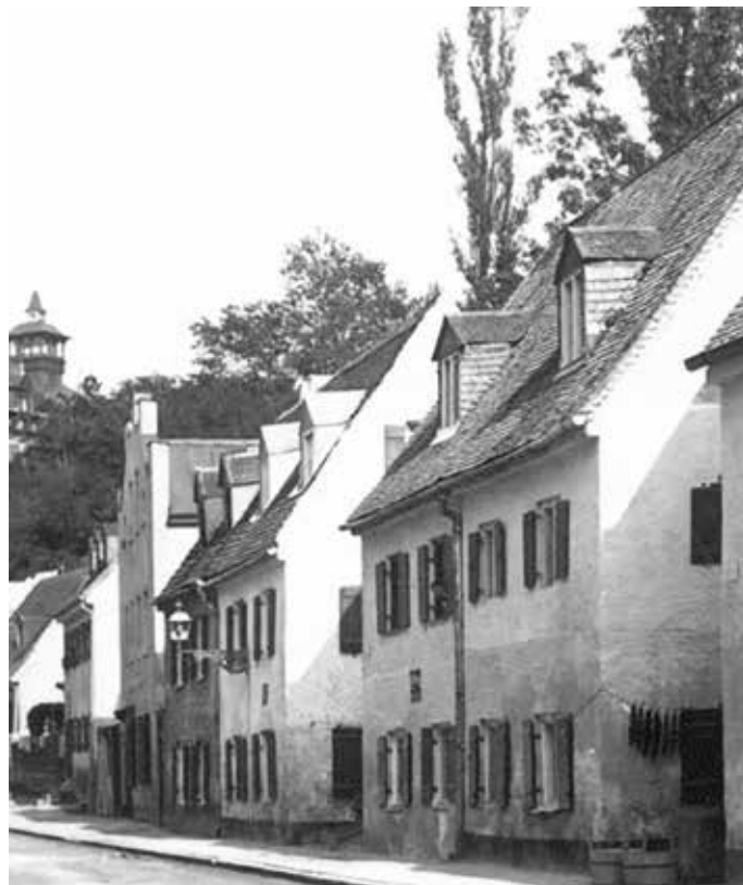
Im Vordergrund das Haus Nummer 39 mit zwei Dachgauben. Davor erreicht man über eine Stiege das Haus Nummer 41 (siehe Zeichnung nebenan).
