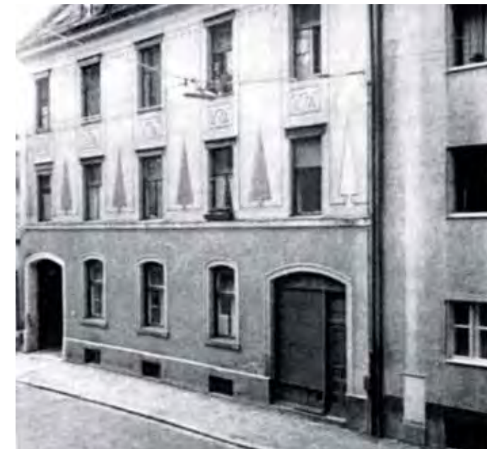
Die Nockherstraße 40 kurz vor dem Abbruch. Foto 1972
