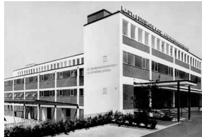
Lager und Verwaltung der Firma Kaut-Bullinger an der Nockherstraße
