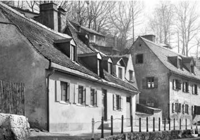
Das Haus nach der Umwandlung des Ziegenstalls in eine Wohnung. In der Bildmitte, an der Hangkante, die Holz-und Heuhütte von Haus 25. Foto um 1930, Denkmalamt.
