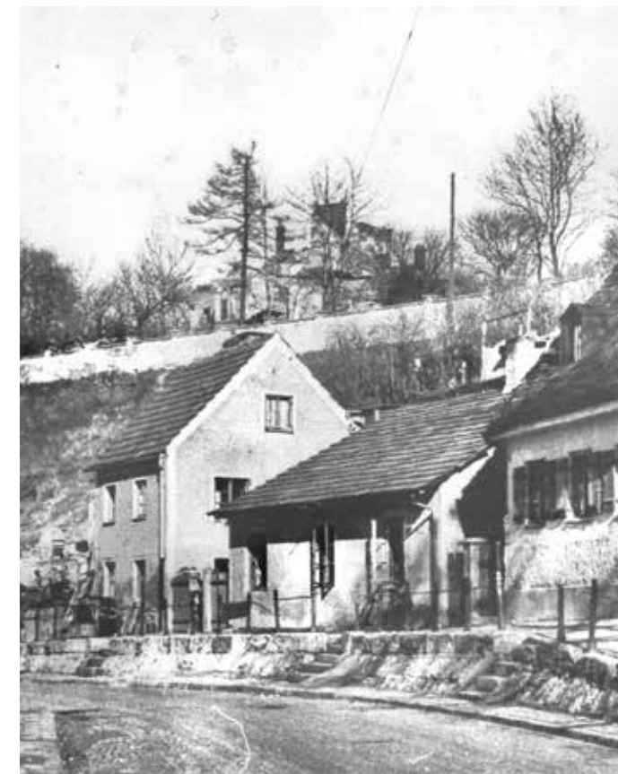
Das zerstörte Satteldach wurde als Notmaßnahme durch ein Pultdach ersetzt. Foto Familie Moser, um 1950
